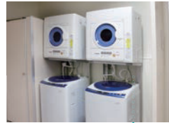
● 洗面・洗濯室 Wash room/laundry
