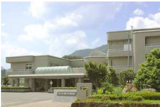
西予市立野村病院 施設外観
