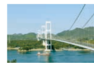
来島海峡大橋
